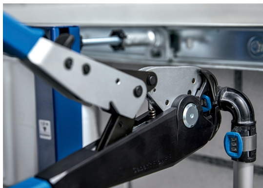
FlowFit ručni alat za stiskanje može se upotrijebiti za promjere cijevi u rasponu d16-d40.
